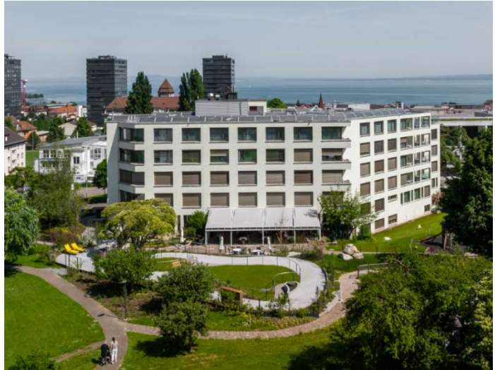
Das PeLago nach der Sanierung
