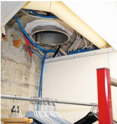
Schmutzige Wäsche fällt durch Rohre direkt in die Lingerie.
