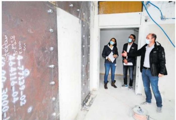
Wände werden mit Stahlplatten verstärkt, um Türen herausfräsen zu können.
